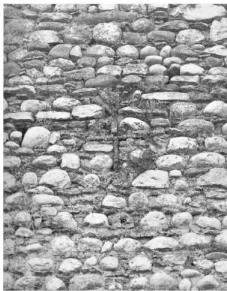
Στη βόρεια καλύτερα σωζόμενη πλευρά των βυζαντινών τειχών σχηματίζεται σταυρός με πλίνθους (φωτ.1953).
