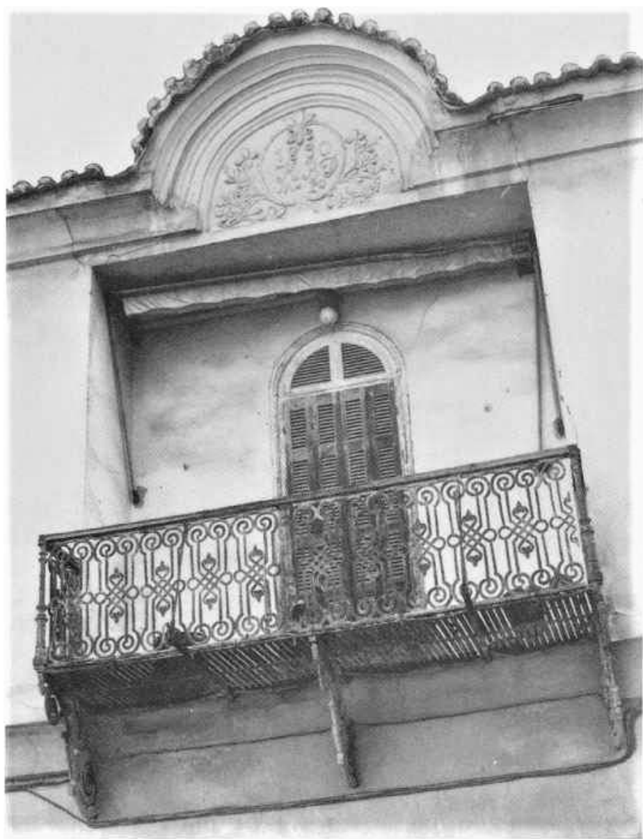
3. Η διόροφη κατοικία της οικογένειας Δαβέλα στη Δράμα (οδός Ελ. Βενιζέλου). Στην πρόσοψη του κτιρίου και σε κυκλικό άνοιγμα της οροφής υπάρχει η χρονολογία 1890 με τα αρχικά του ονόματος του ιδιοκτήτη (Κ.Β.Δ.). Σύμφωνα με μαρτυρία του «Οδοιπορικού» τη χρονική περίοδο που εγγίζει το 1890 στη Δράμα «εκτίσθησαν πολλά οικία και χάνια» (φωτ. 1986).
