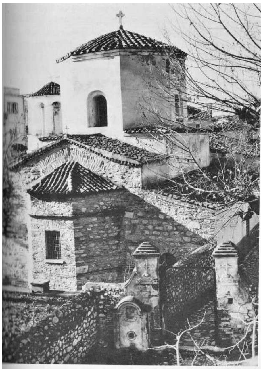
Η ανατολική όψη του ναού της Αγίας Σοφίας (φωτ.1971).
